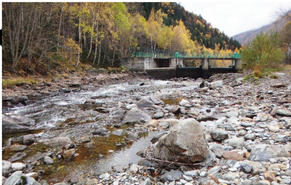
Tram de riu represat, presa de Montalto. Foto: M. Ventura
